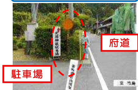
カーブミラー補修
