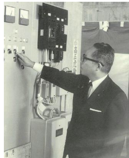
▲送水ポンプのスイッチを入れる塩見元市長(昭和44年)
