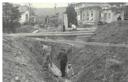
▲浄水場内拡張工事 (昭和28年)
