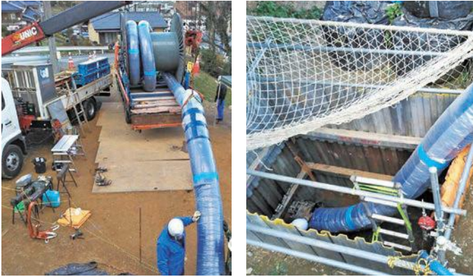
▲堀山第1配水池系統送水管更新 (使用しなくなった管の中に新しい管を引き込んでいます)
