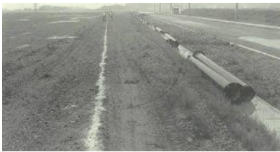
▲長田野工業団地内の配水管布設（昭和47年）
