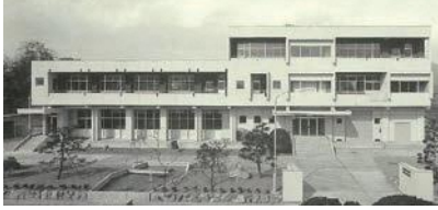
▲公営企業部庁舎完成（昭和44年）
