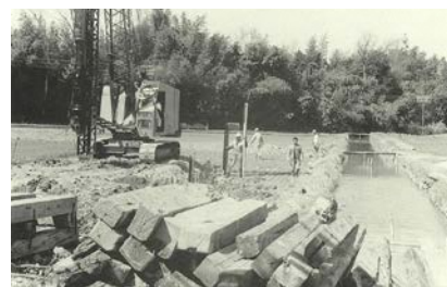
▲公営企業部庁舎の杭打作業(昭和44年)
