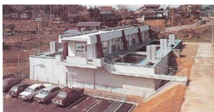
▲増設された急速ろ過池（昭和53年）
