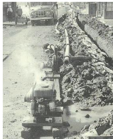
▲修斉小学校付近の配水管布設工事 (昭和30年頃)
