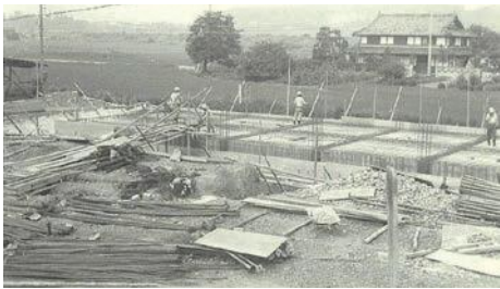
▲建設中の第3浄水池（昭和46年）
