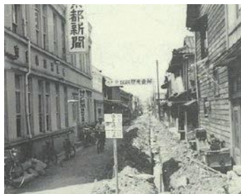
▲内記6丁目付近、配水管増設工事 (昭和30年頃)
