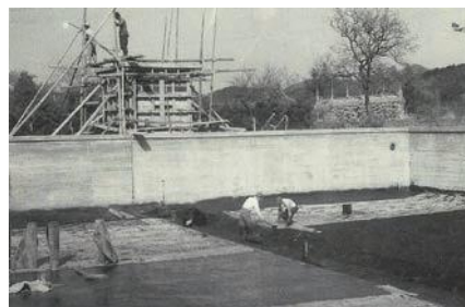
▲工事中の第4号ろ過池 (昭和28年)
