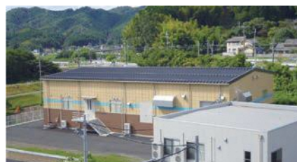
▲堀浄水場 膜ろ過施設完成（平成28年）
