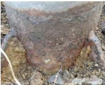
□標識柱の根元が錆びている
