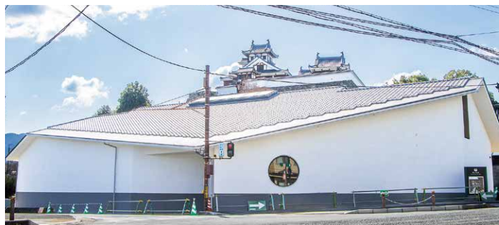
建設中の福知山鉄道館「フクレル」 (3月24日時点)
