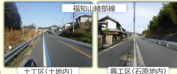
土工区(土地内)
