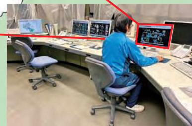
▲上下水道部庁舎。24時間365日監視員が常駐しています
