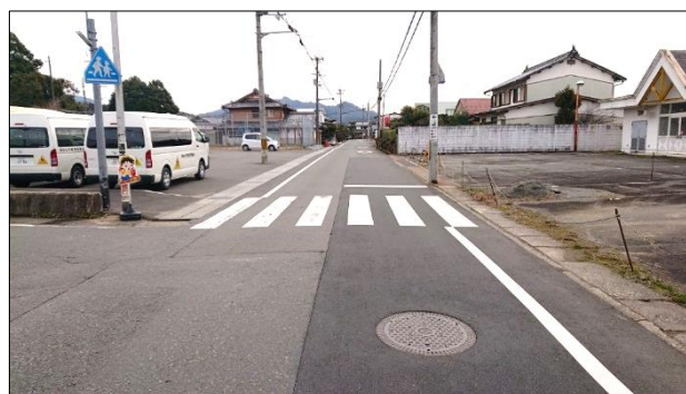
下水道雨水排水路の新設・改良
