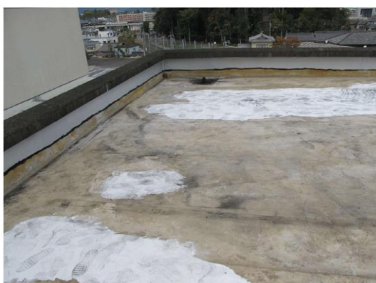
桃映中学校管理・東校舎屋上 (現況)
