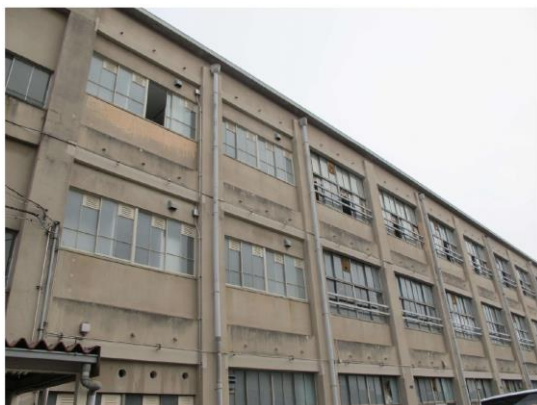
南陵中学校北校舎外壁 (現況)
