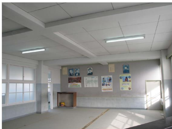
惇明小学校音楽室 (現況)
