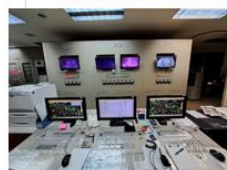
中央運転監視設備改修工事
