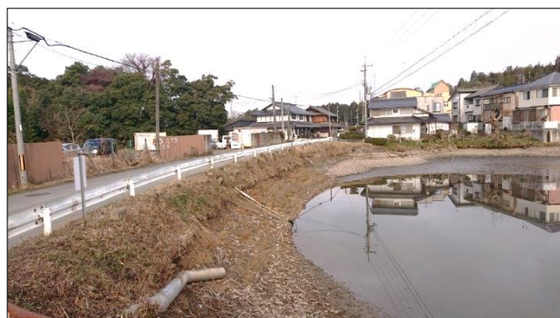
ため池堤体補強
