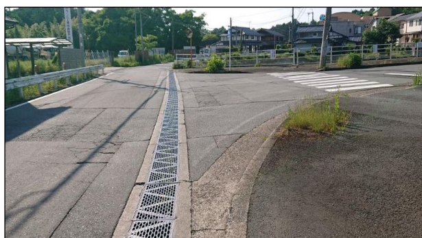
道路排水施設の改良
