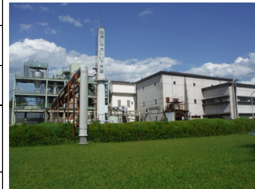
福知山終末処理場 汚泥有効利用施設の建設
