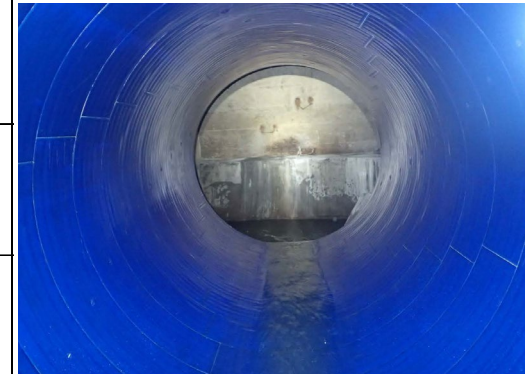
中部幹線管路更生工事
