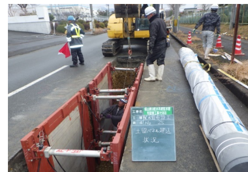
水道管路耐震化
