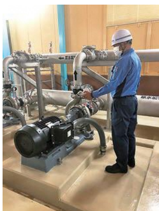
▲水道施設内の機械設備点検をしている様子
