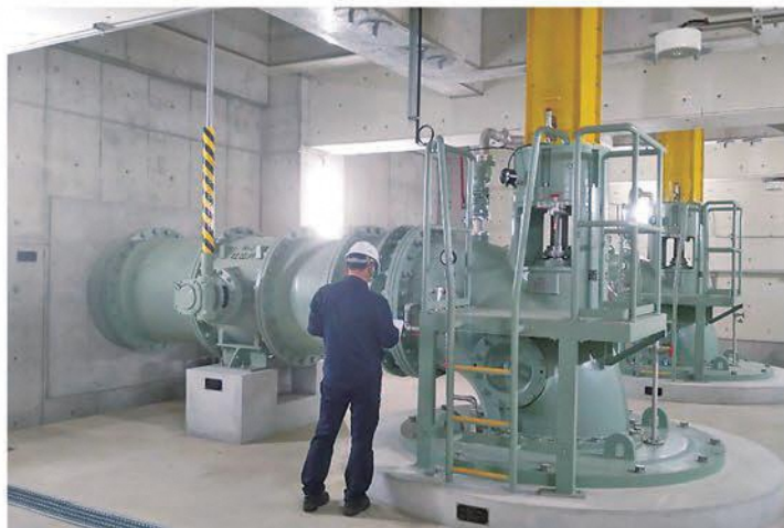
▲段畑雨水ポンプ場内の機械設備を点検している様子
