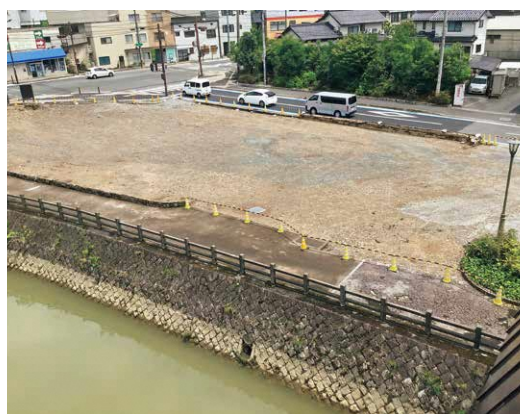
「昇龍橋」から見たポップランド建設予定の親水公園
