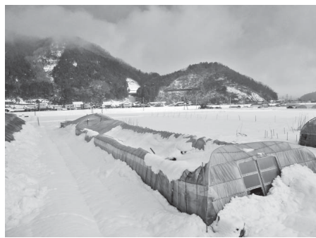
大雪により被災したビニールハウス
