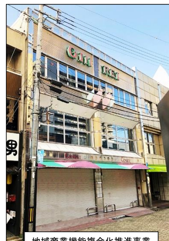
地域商業機能複合化推進事業 で改修を計画している建物
