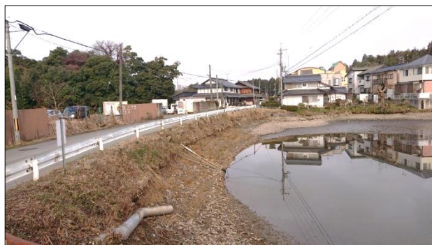
ため池堤体補強
