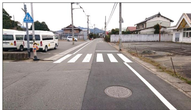
下水道雨水排水施設の新設・改良
