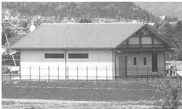
96年完成の戸田浄水場
