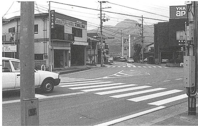
改修が待たれる国道429号線▶
