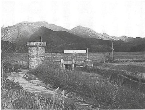
▲ポンプ設置を要望する弘法川の捷水路
