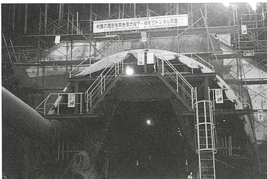
順調に工事が進むゆずりトンネル
