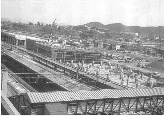
福知山駅構内の高架工事状況
