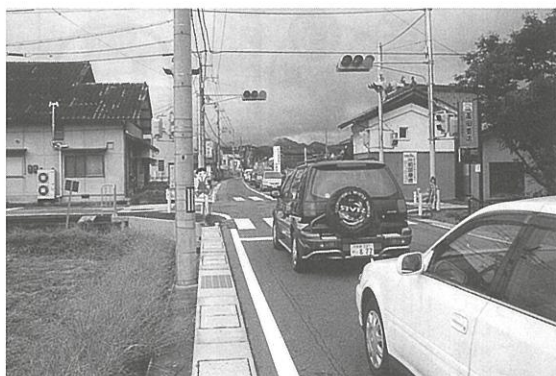
交通量の増加により急がれる429号の安全対策
