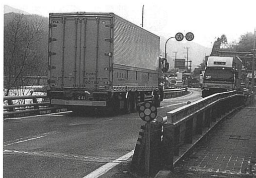
大型車両の離合が難しく、架け替えが望まれる国道9号佐々木川橋
