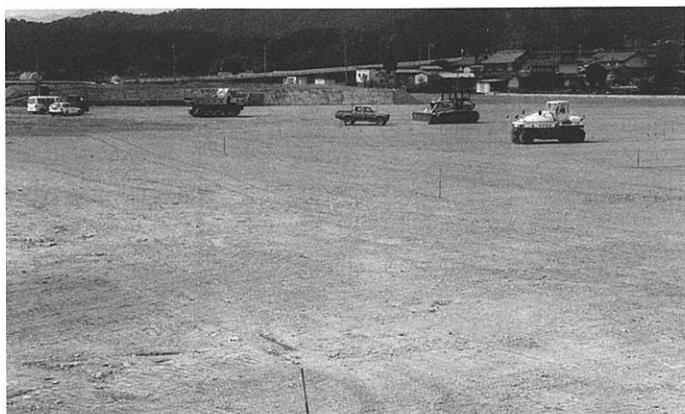
宅地造成工事が進む戸田地区
