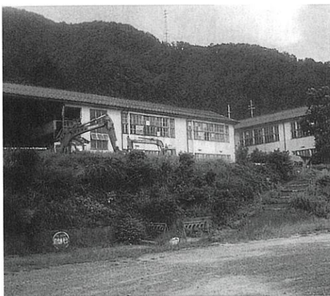
授産施設建設のため解体進む旧天津小学校本館
