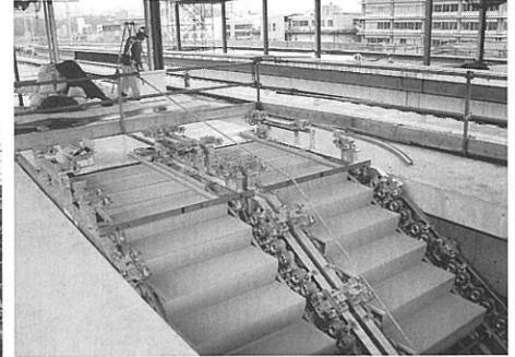
エスカレーター設置作業
