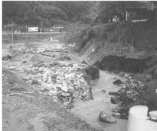
坂浦地区の災害状況
