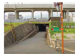
工事が進む岸本ガード周辺
