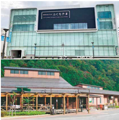
公共施設で現在Wi-Fiを利用できるのは 2施設
