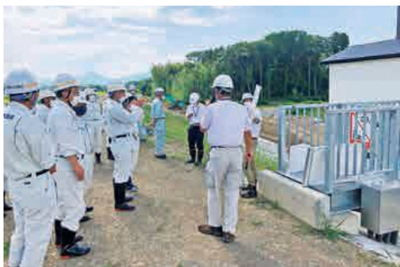
前田地区で工事が進行中の連続堤防と樋門
