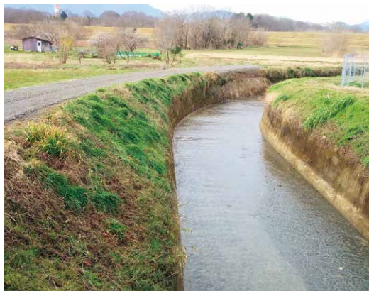
浚渫工事を実施中の市管理河川（西谷川）
