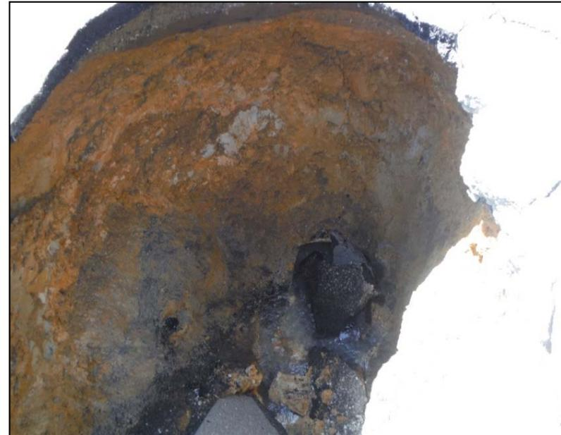
H27.5.26 下水道管破損による道路陥没（市道多保市土師線）
