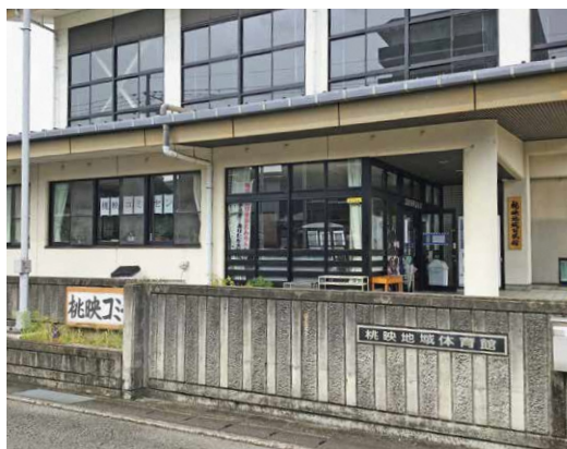
新たな地域拠点施設として、施設整備を待つ、桃映地域公民館
