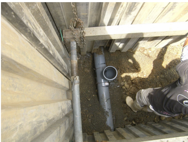
13 支管取付完了
