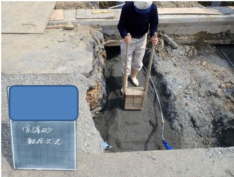
16 砂基礎転圧(管上部)
