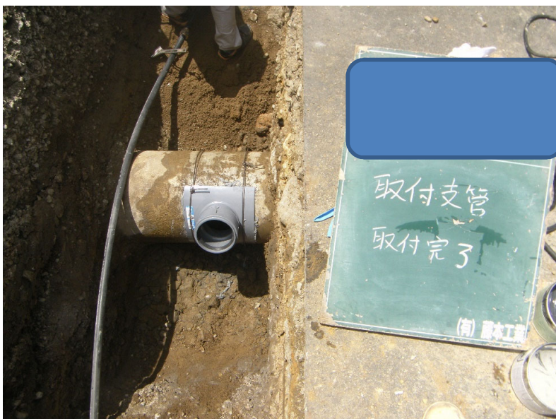
13 支管取付完了
