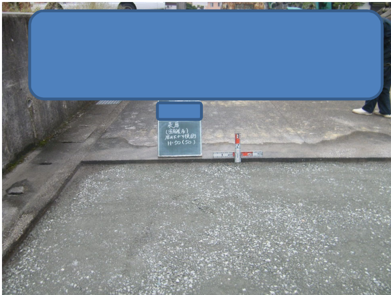
23 舗装本復旧 路盤工完了
