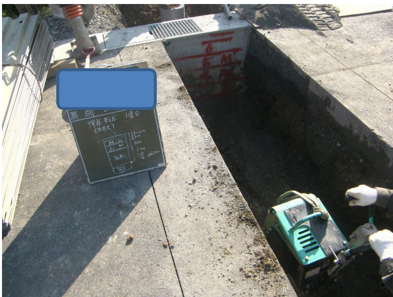
18 取付管埋戻し転圧
