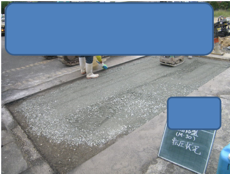
22 舗装本復旧 路盤工
