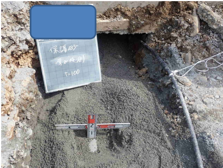
17 砂基礎厚測定
