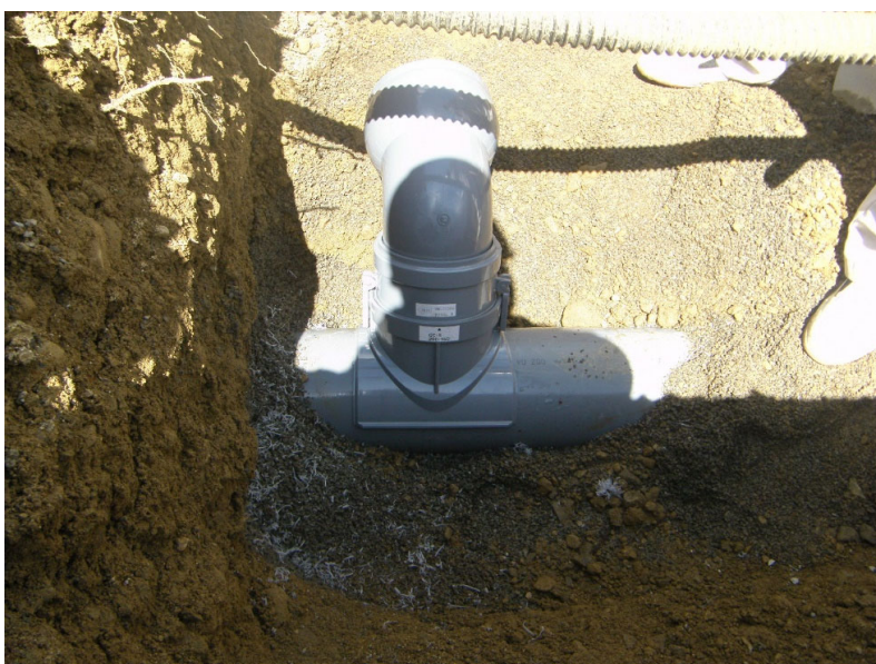
13 支管取付完了
