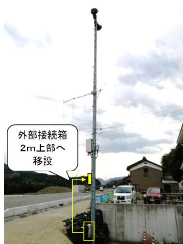
下天津防災行政無線屋外拡声子局 機器等移設イメージ
