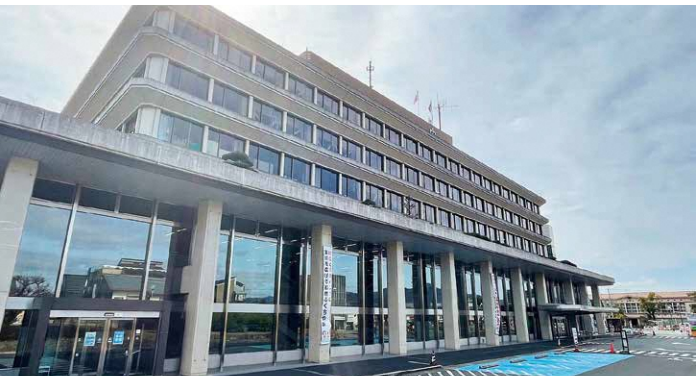
事務室の照明をLED照明に交換する市庁舎
