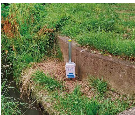
水路の横に設置した浸水検知センサー
