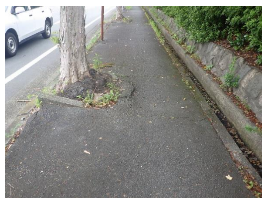
前田岩間線（植樹柵撤去）
