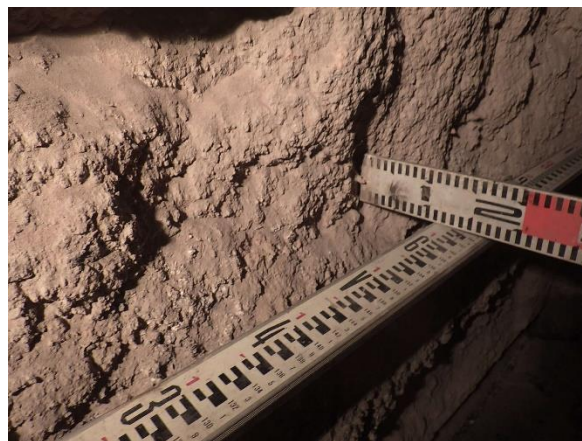
焼却炉燃焼室内部
