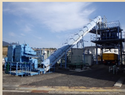
ポンプ場施設更新
