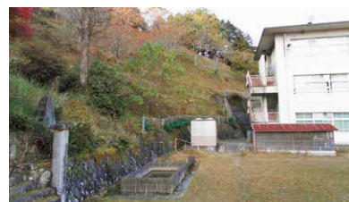
旧三岳小学校周辺の法面
