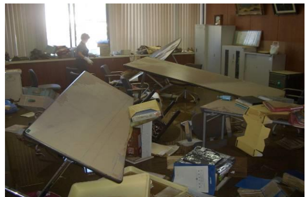
大江支所1階（9月17日9時頃撮影）
