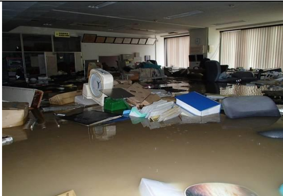
大江支所1階（9月16日9時頃撮影）
