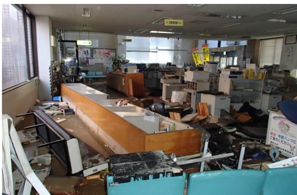
大江支所1階（9月17日9時頃撮影）
