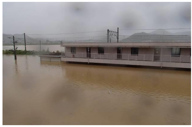
大江支所車庫・倉庫（9月16日9時30分撮影）
