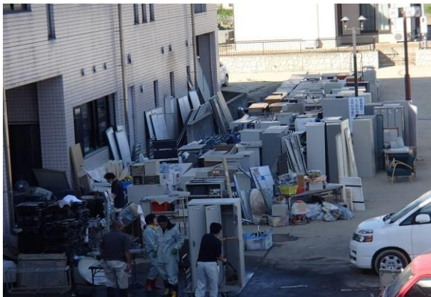
支所裏駐車場（災害復旧作業 9月20日撮影）
