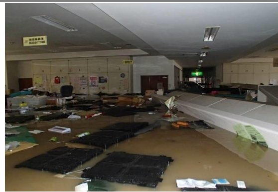
大江支所1階（9月16日9時頃撮影）
