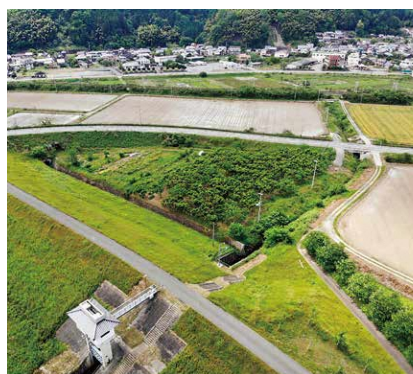
排水ポンプ設置予定地の 大江町河守～公庄地区
