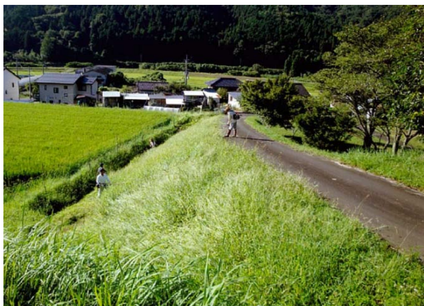
農道法面の草刈り
