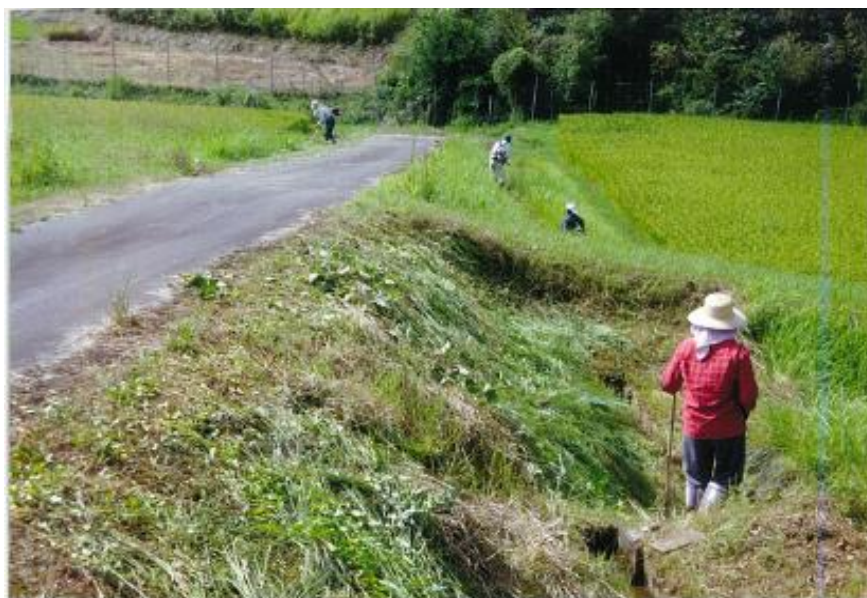
農道法面の草刈り
