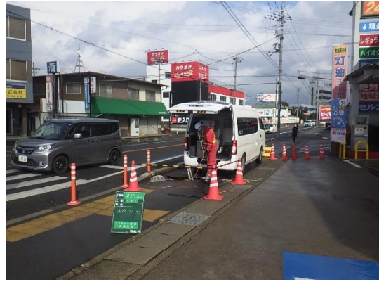
写真2-1-7 管きょ調査作業の状況
