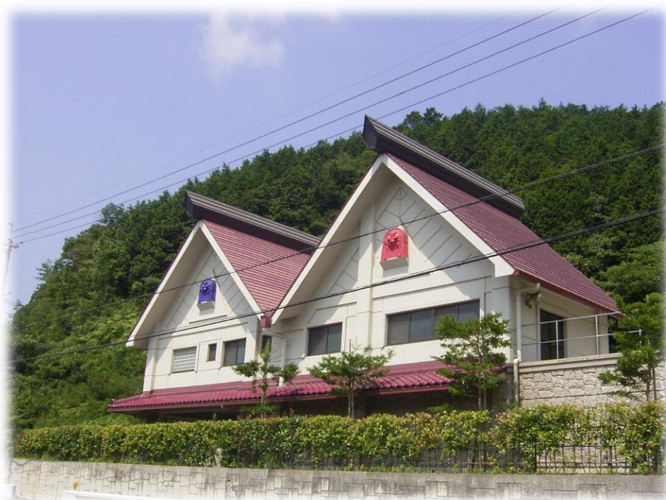
北有路浄化センター
