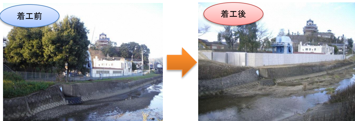
写真2-1-4 止水壁（蛇ヶ端ポンプ場）
