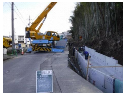
写真2-1-1 バイパス管内貯留工事施工状況(左)、雨水排水路増強工事施工状況(右)
