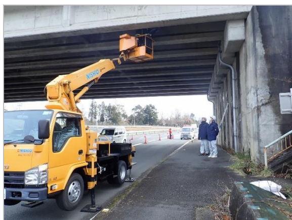
橋りょう点検状況 (長田野地内)
