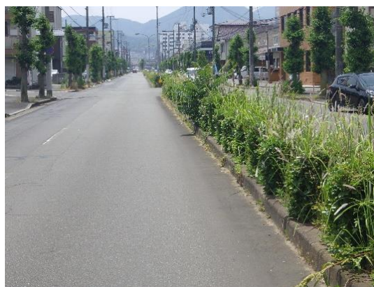
福知山停車場鋳物師線 (中央分離帯改良)
