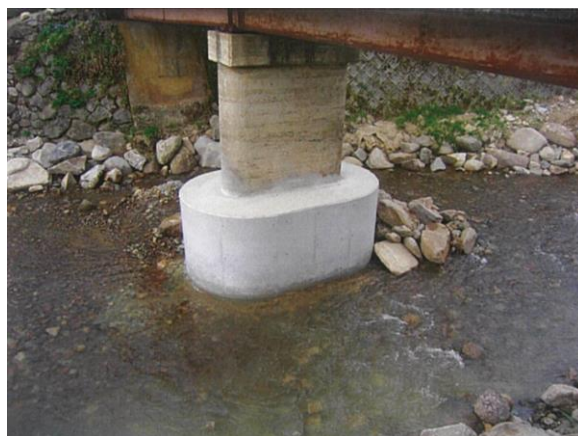
橋りょう修繕状況 (寺入橋)
