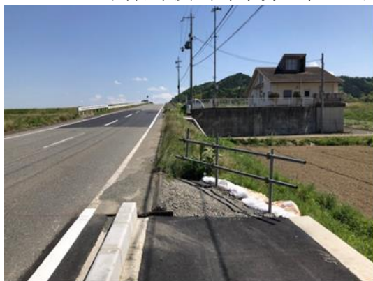
広小路勅使線 (道路改良工事)
