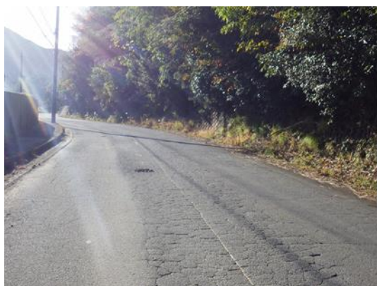
川北荒木線 (舗装補修)
