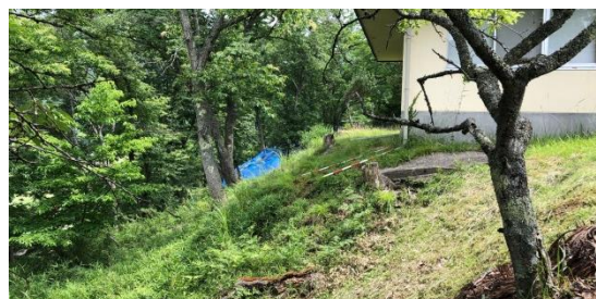
山村基幹集落センター背後地法面
