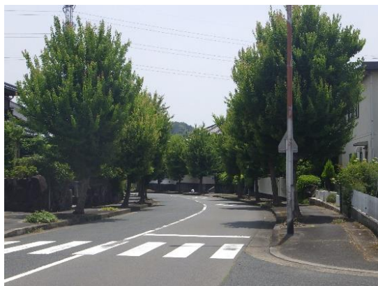
下荒河神谷線 (街路樹柵撤去等)
