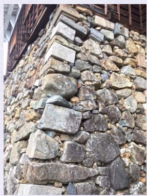
石垣の隅角部と転用石
