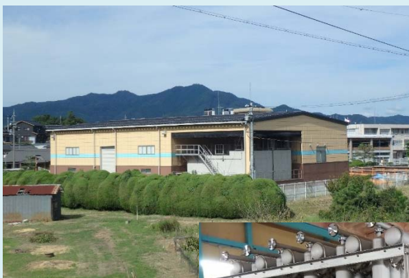
堀浄水場（膜ろ過棟）
