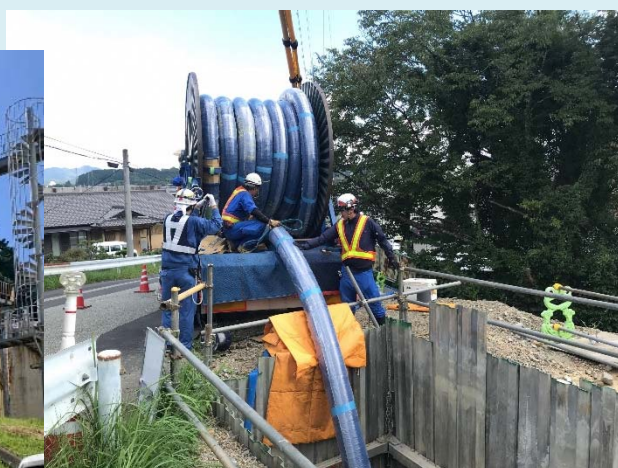
送水管更新（管内挿工法 口径 200mm）
