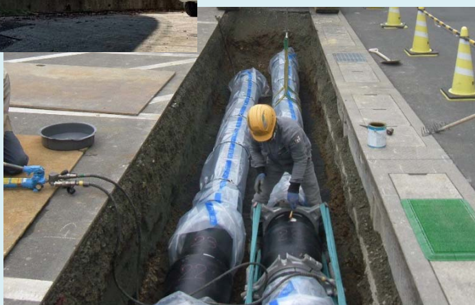
送水管更新（D I P - N S 口径 350mm）
