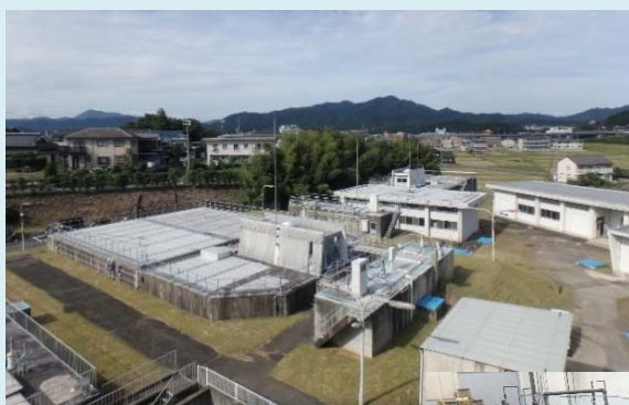
堀浄水場（急速ろ過施設）
