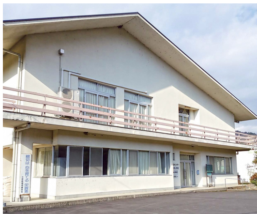
再配置計画が協議されている川合集落センター
