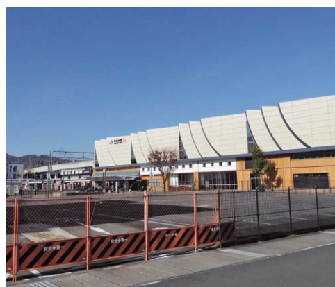
駅南口のホテル建設予定地
