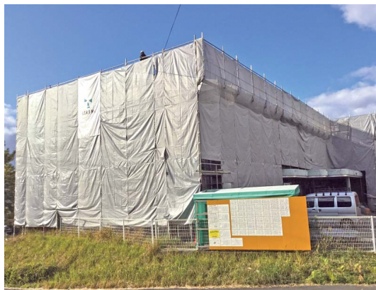
情報学部開設に向けて改修工事が進む3号館
