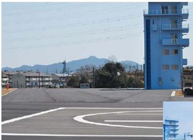
消防防災訓練場
