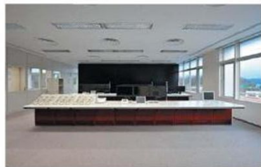
消防指令センター
