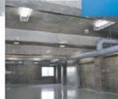
備蓄倉庫(2F)
