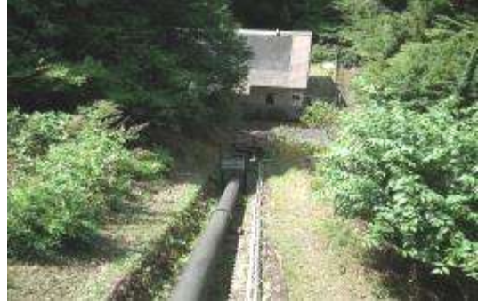
内宮発電所（関西電力）【大江町大字内宮】
