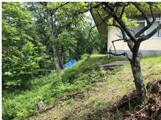
山村基幹集落センター（北陵地域公民館） 背後地法面
