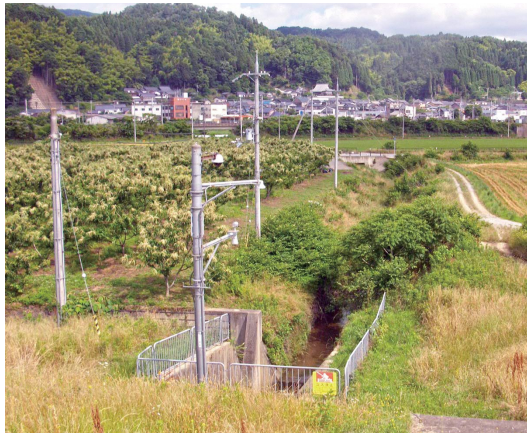
内水対策が計画されている公手川樋門付近の状況
