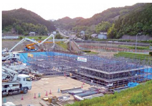
府で施工中の弘法川の新設排水機場
