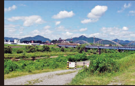
④① 土師川堤防と水道橋 d-4
