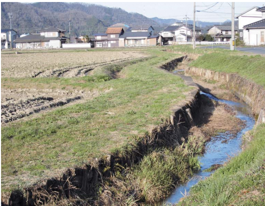
内水被害をくり返す大谷川
