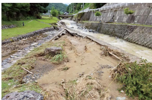
親水公園の被害状況
